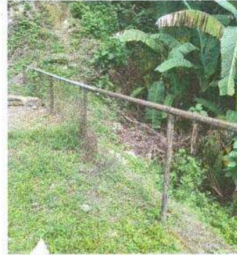
Foto 8: Reparacion de tubo hg y malla galvanizada
